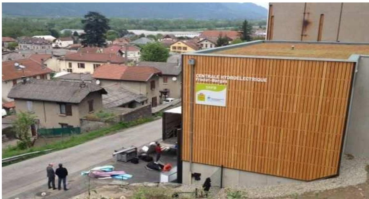
La centrale a un fonctionnement dit « au fil de l'eau ». L'eau n'est pas stockée et l'électricité est produite au gré des débits du cours d'eau.
